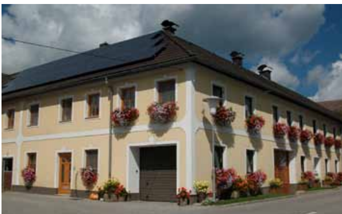
2012 wurde in eine 20 kW-PV-Anlage investiert. Der erzeugte Strom wird ins Netz eingespeist, somit finanzieren sich die Stromkosten des Betriebes.
